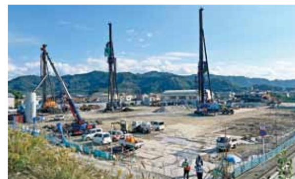
11月の工事現場（保田中学校跡地）の様子
