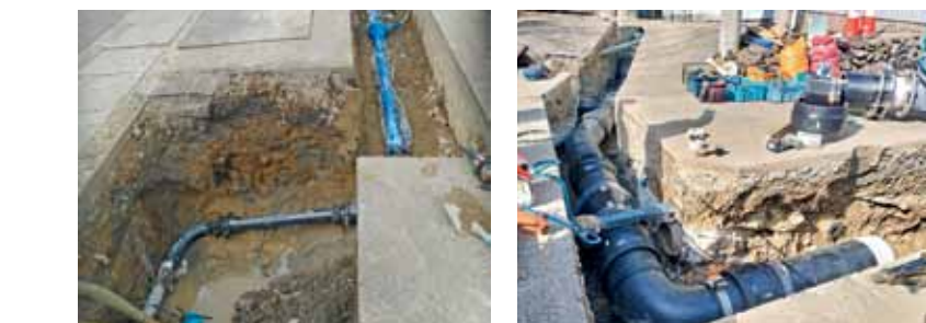
耐震性に優れた管に取り替えている様子
