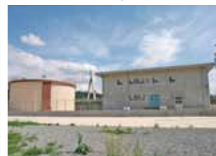
水道施設の維持・管理
