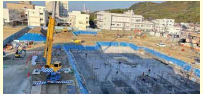
工事が進んでいます！
