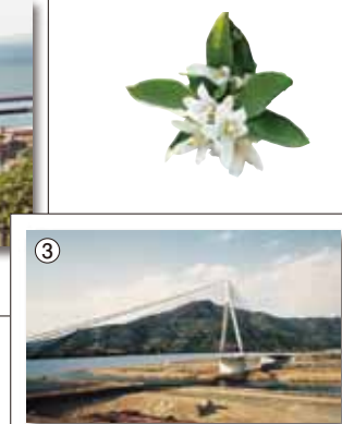
有田中央大橋完成（平成10年）
