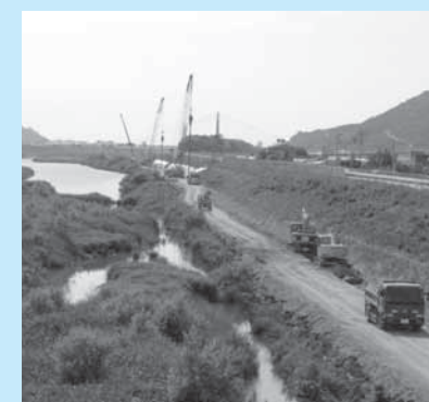
堤防強化工事の様子
