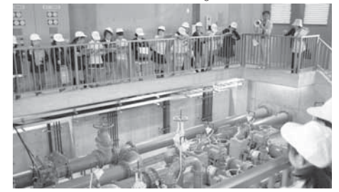
送水ポンプを見学
