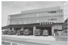
完成した消防庁舎
