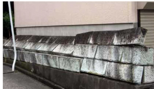
出典 (一財) 消防科学総合センター
