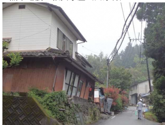
熊本地震の被災家屋（西原村）
