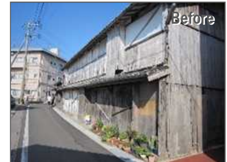
空き家の除却
