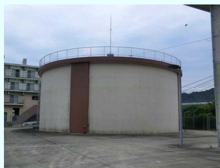
下中島第2(低区)配水池
