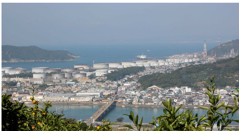
写真 2-3 石油精製工場
